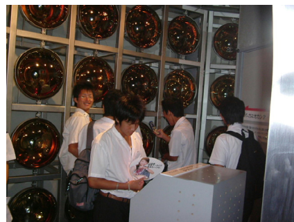
スカイドーム神岡内・光電子増倍管
